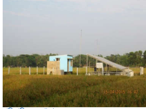
কক্সবাজারে স্থাপিত সৌর শক্তিচালিত সেচ পাম্প
