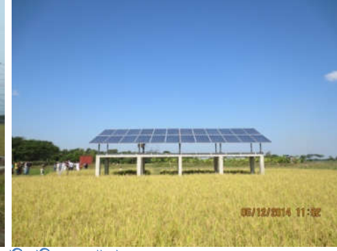
হাকালুকি হাওরে সৌর শক্তিচালিত সেচ পাম্প
