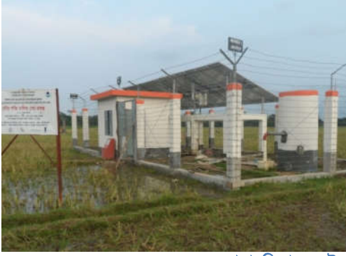
হাকালুকি হাওরে সৌর শক্তিচালিত সেচ পাম্প
